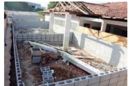
Neste mês foram iniciadas as obras de reforma e ampliação da EMEB Sático Alves de Souza (Vila Ouro Verde). A unidade, uma das mais antigas da região, receberá nova pintura e redes hidráulica e
